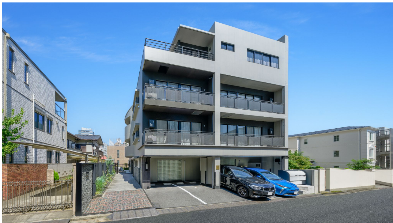
KYŌ RESIDENCE 新宿代々木完成外観
